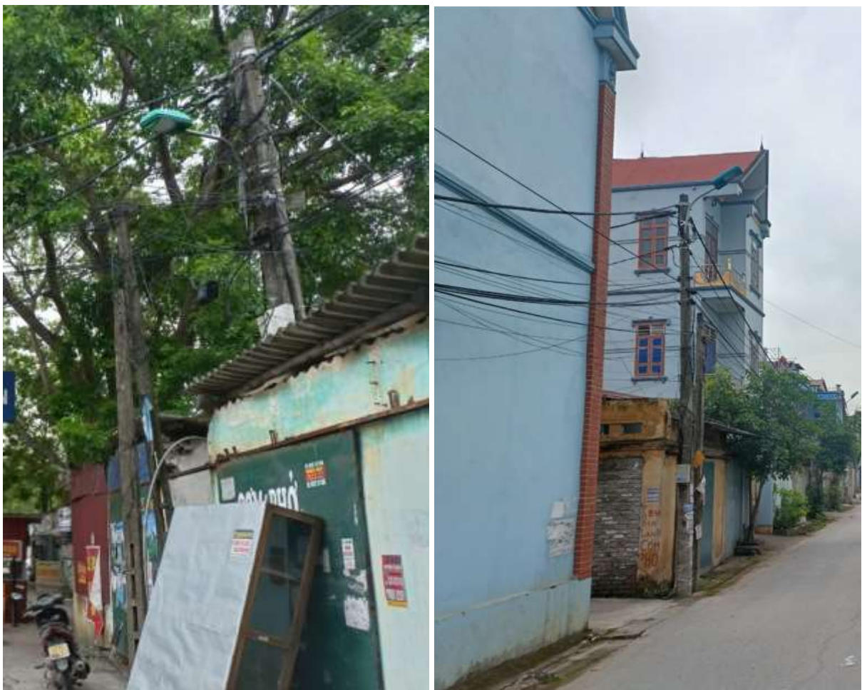
Hình 45. Cột điện bị xuống cấp trên tuyến phố Nguyễn Văn Ty.
