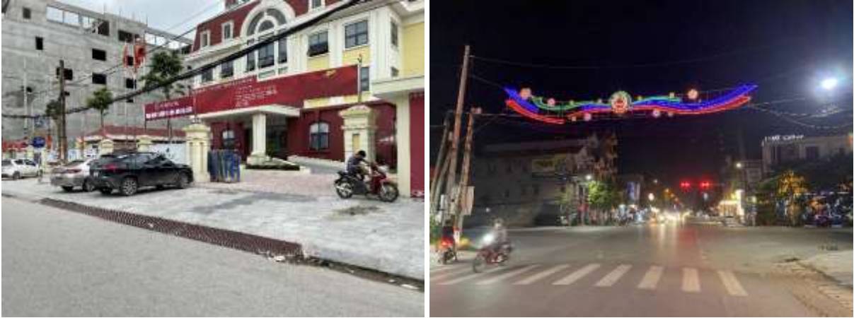
Hình 20. Hệ thống đường dây dẫn được bó gọn và hệ thống chiếu sáng trên tuyến phố Thân Nhân Trung.
