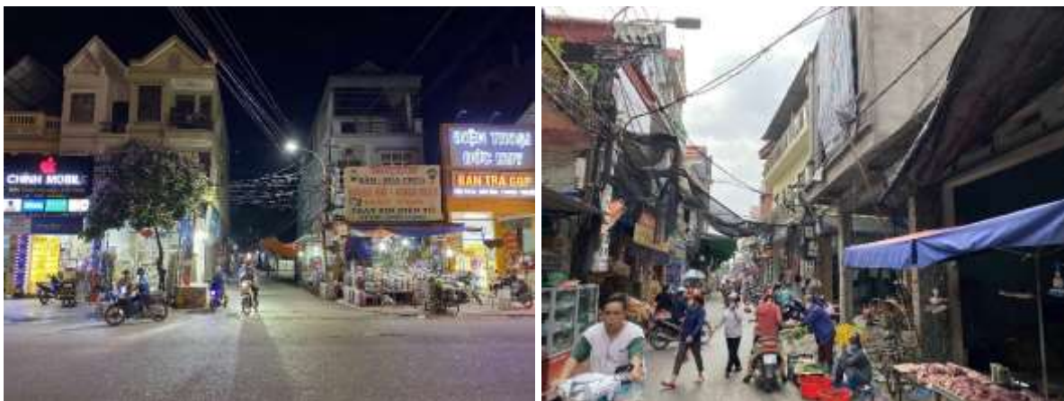
Hình 102. Hệ thống đường dây dẫn điện, thông tin liên lạc và chiếu sáng trên tuyến phố Thân Nhân Tín.
