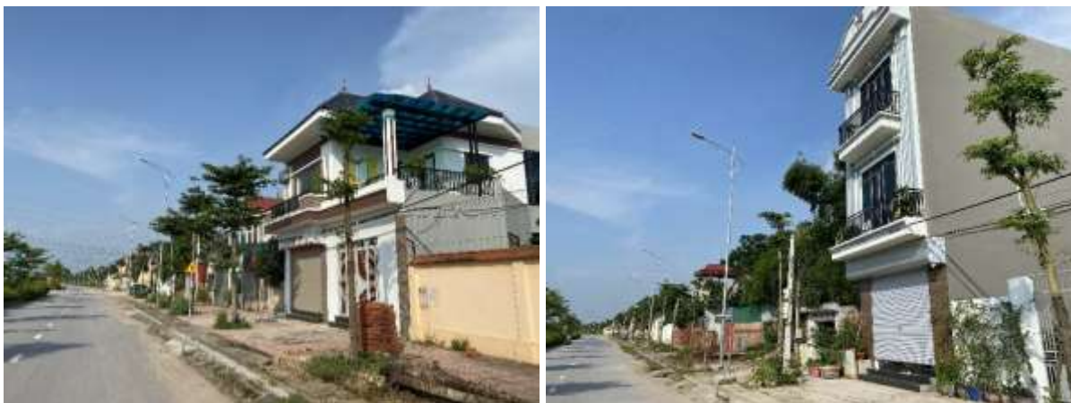
Hình 35. Vỉa hè để vật liệu xây dựng và lòng đường đang được xây dựng trên tuyến phố Dương Quốc Cơ.
