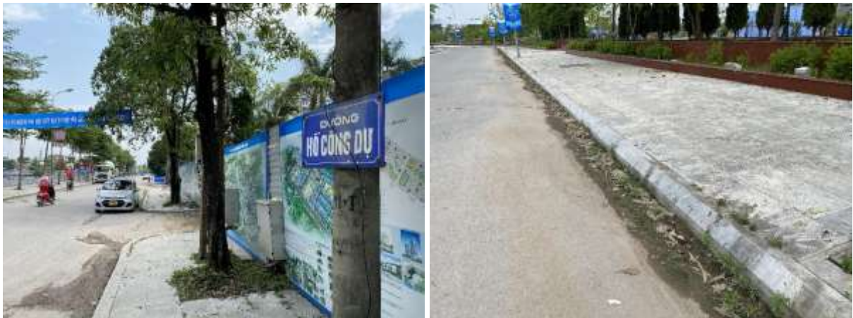
Hình 56. Vỉa hè trên tuyến phố Hồ Công Dự.
