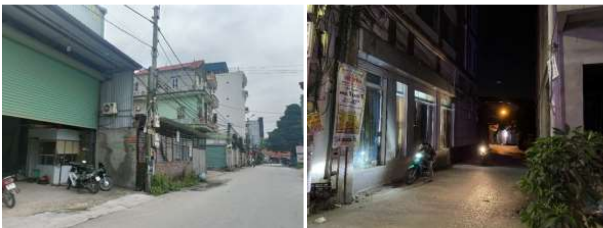
Hình 110. Hệ thống đường dây dẫn điện, thông tin liên lạc và chiếu sáng trên tuyến phố Ninh Khánh.
