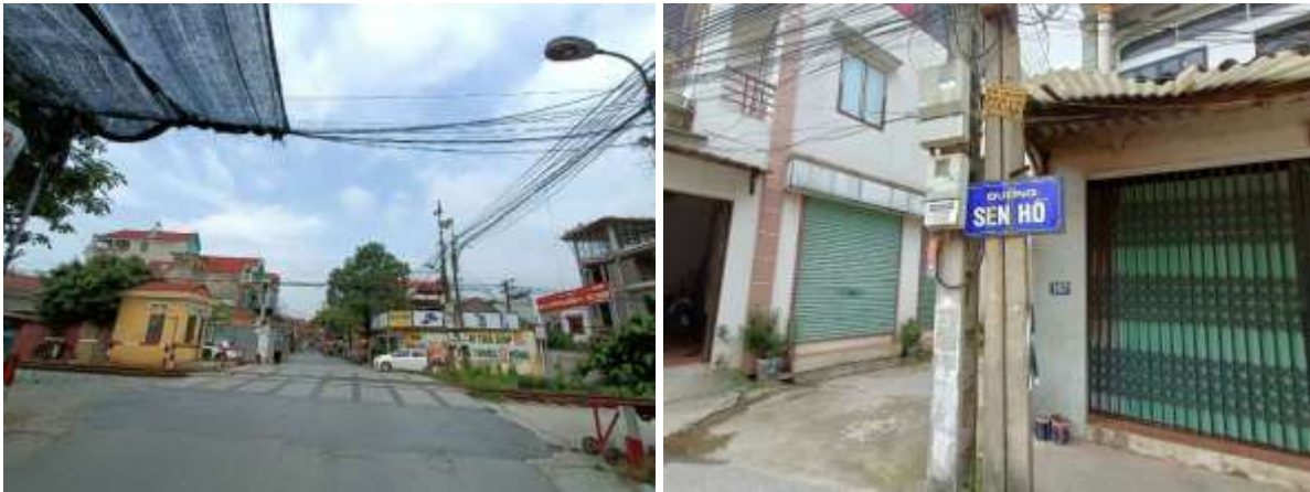
Hình 82. Đèn tín hiệu và biển chỉ dẫn trên tuyến phố Sen Hồ.
