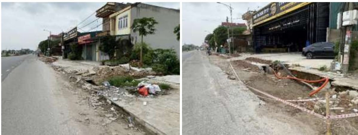
Hình 25. Vía hè để vật liệu xây dựng và lòng đường đang được xây dựng trên tuyến phố Hoàng Hoa Thám.
