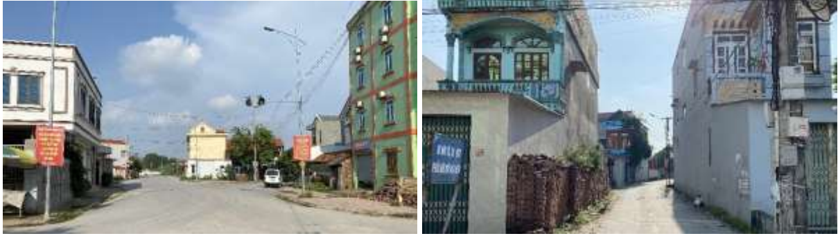
Hình 38. Đèn tín hiệu và hệ thống biển báo trên tuyến phố Dương Quốc Cơ.
