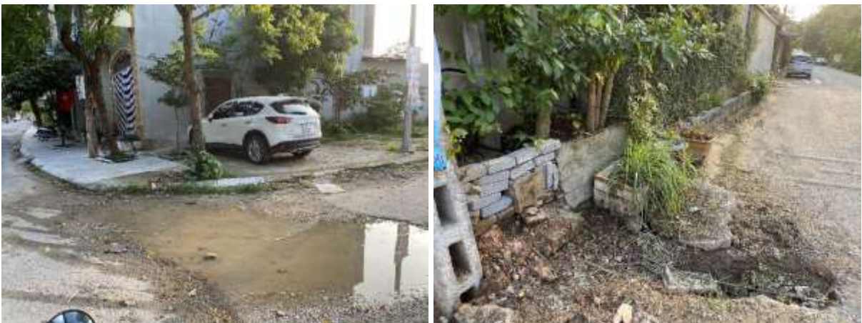
Hình 54. Tình trạng đọng nước trên tuyến phố Nguyễn Hồng.
