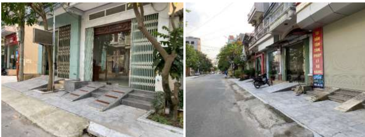
Hình 48. Vỉa hè trên tuyến phố Nguyễn Hồng bị lấn chiếm.
