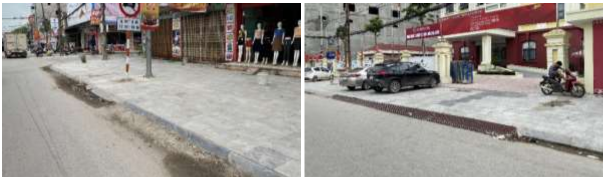
Hình 14. Vỉa hè tuyến phố Thân Nhân Trung.
