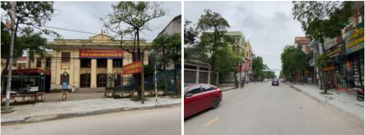
Hình 24. Một số công trình kiến trúc trên tuyến phố Hoàng Hoa Thám.
