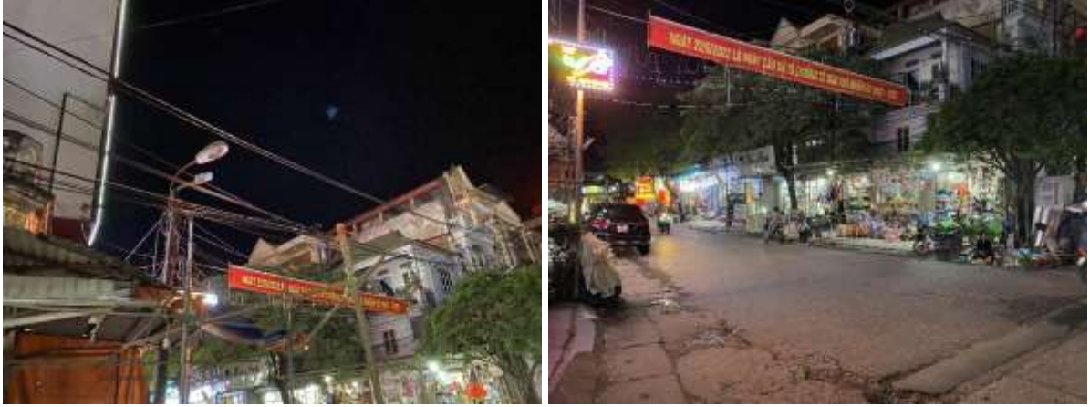
Hình 84. Hệ thống đường dây dẫn điện, thông tin liên lạc và chiếu sáng trên tuyến phố Sen Hồ.
