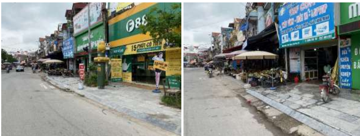
Hình 30. Chất lượng mặt đường, vỉa hè và vỉa thực trạng xây thêm gờ tự phát trên tuyến phố Hoàng Hoa Thám.
